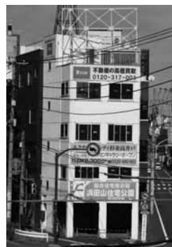
耐震改修中の高井駅前ビル
